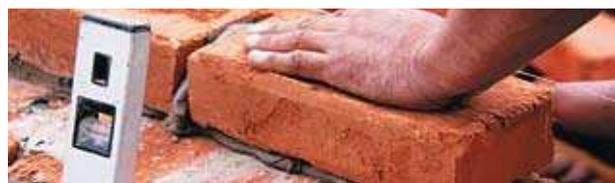
**3** С НЕБОЛЬШИМ УСИЛИЕМ ПРИЖАТЬ КИРПИЧ К ПРЕДЫДУЩЕМУ, С ФИКСИРОВАНИЕМ НА НЕСКОЛЬКО СЕКУНД
