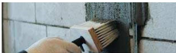
**4** ПРОИЗВЕСТИ НАНЕСЕНИЕ ГИДРОИЗОЛЯЦИОННОГО МАТЕРИАЛА БИРСС ГЕРМОЛАСТИК (КИСТЬЮ, ВАЛИКОМ).
