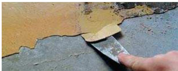
**1** ПОДГОТОВИТЬ ПОВЕРХНОСТЬ С ПОМОЩЬЮ СПЕЦИАЛЬНЫХ ИНСТРУМЕНТОВ (ШПАТЕЛЯ, ЩЕТКИ).
