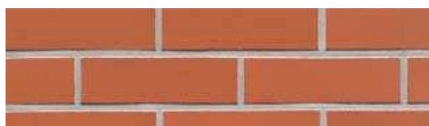
**6** ПОСЛЕ БАЗОВОГО РЯДА КИРПИЧЕЙ, ПОСЛЕДУЮЩИЕ УКЛАДЫВАЕМ СО СМЕЩЕНИЕМ ВЕРТИКАЛЬНЫХ ШВОВ.
