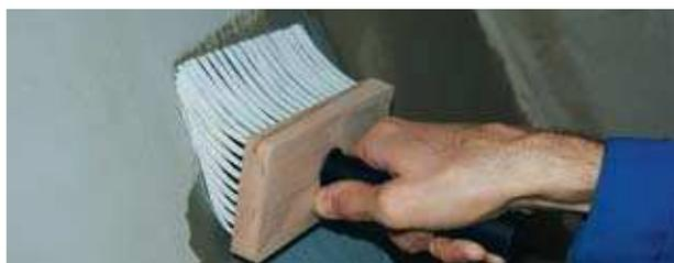
**2** УВЛАЖНИТЬ ИЛИ ОТГРУНТОВАТЬ ПОВЕРХНОСТЬ, В ЗАВИСИМОСТИ ОТ ЕЕ ВПИТЫВАЮЩЕЙ СПОСОБНОСТИ .
