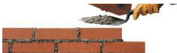
**2** КЛАДОЧНЫЙ РАСТВОР НАНОСИТЬ НА СТЫКОВОЕ - ВЕРТИКАЛЬНОЕ И ГОРИЗОНТАЛЬНОЕ ОСНОВАНИЕ КИРПИЧА.
