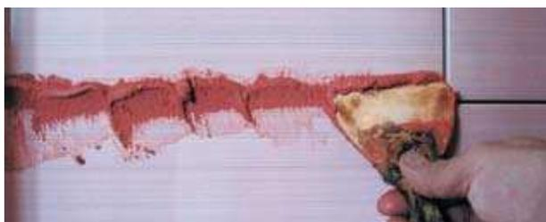
**5** ЧЕРЕЗ СУТКИ ПОСЛЕ УКЛАДКИ ПЛИТКИ, ШВЫ ПРОЧИСТИТЬ ОТ ОСТАТКОВ КЛЕЯ. РЕЗИНОВЫМ ШПАТЕЛЕМ ВЫРОВНЯТЬ ФУГОВОЧНЫЙ СОСТАВ, ПОСЛЕ ЧЕГО ПРОТЕРЕТЬ ПЛИТКУ СУХОЙ ВЕТОШЬЮ.
