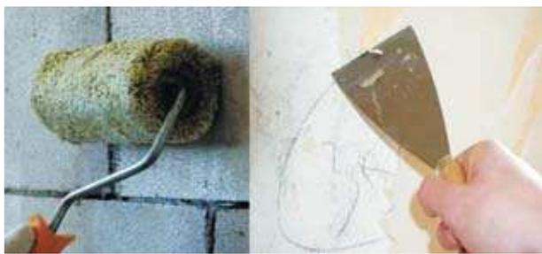
**1** ОСНОВАНИЕ ДОЛЖНО БЫТЬ РОВНЫМ, ЧИСТЫМ, ПРОЧНЫМ, БЕЗ РАЗДЕЛИТЕЛЬНЫХ СЛОЕВ И ЗАГРЯЗНЕНИЙ. ПЕРЕПАД УРОВНЕЙ ПО ГОРИЗОНТАЛИ/ВЕРТИКАЛИ НЕ ДОЛЖЕН ПРЕВЫШАТЬ РЕКОМЕНДУЕМУЮ ТОЛЩИНУ КЛЕЕВОГО РАСТВОРА. В ЗАВИСИМОСТИ ОТ ТИПА ОСНОВАНИЯ ОБРАБОТАТЬ ПОВЕРХНОСТЬ ГРУНТАМИ БИРСС.
