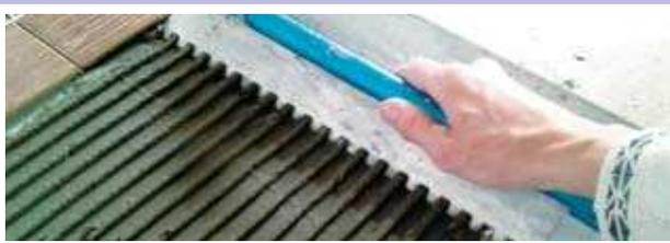
**3** ГОТОВЫЙ КЛЕЕВОЙ СОСТАВ НАНОСИТЬ НА ВЫРОВНЕННОЕ ОСНОВАНИЕ (ПОЛ, СТЕНА) - ЗУБЧАТЫМ ШПАТЕЛЕМ, РАВНОМЕРНО БЕЗ ПРОПУСКОВ.
