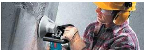
**3** ЗАКРУГЛИТЬ ОСТРЫЕ УГЛЫ ОСНОВАНИЯ ШЛИФОВАЛЬНОЙ МАШИНОК С АЛМАЗНЫМ ДИСКОМ.
