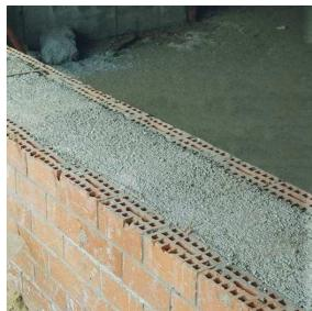
Теплоизоляционное заполнение полых стен
