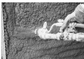
ТЕРМОПОР® наносится вручную и механизированно с помощью штукатурных станций, не требует предварительного выравнивания поверхности и мо-
