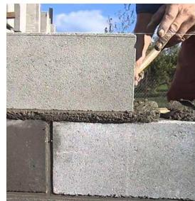
Кладочный раствор для ячеистых бетонов
