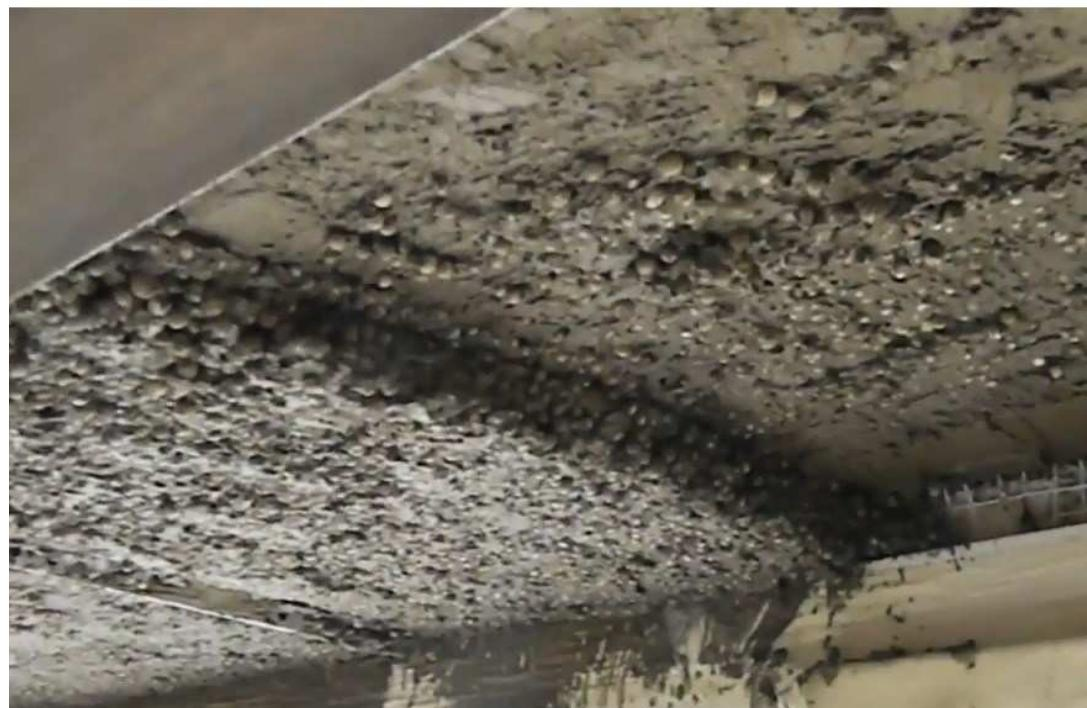
Материал обладает низкой текучестью и легко обрабатывается даже в свежеуложенном виде: позволяет формировать ниши, проемы, штробы под электропроводку без оползания нанесенного слоя.
